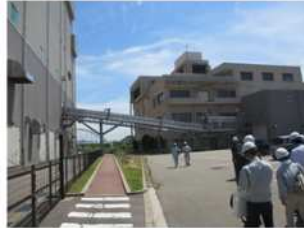
乾燥汚泥搬送コンベヤ 長さ約50mと近い
