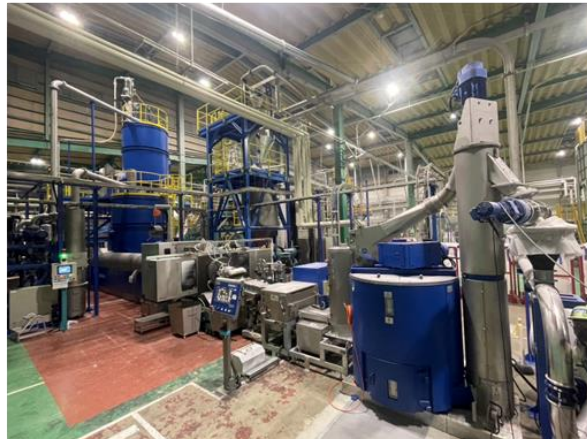
メカニカルリサイクル設備
